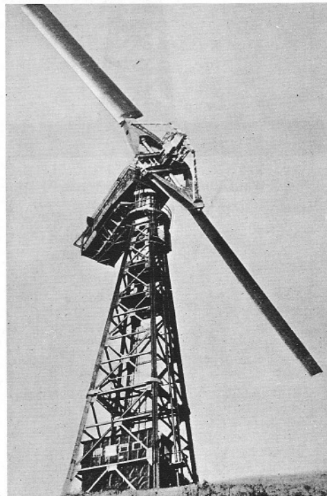
afb 4.6 Smith-Putnam molen op Grandpa's Knob, Vermont in de Verenigde Staten; vermogen 1250 kW; diameter 53,3 meter (1941).
