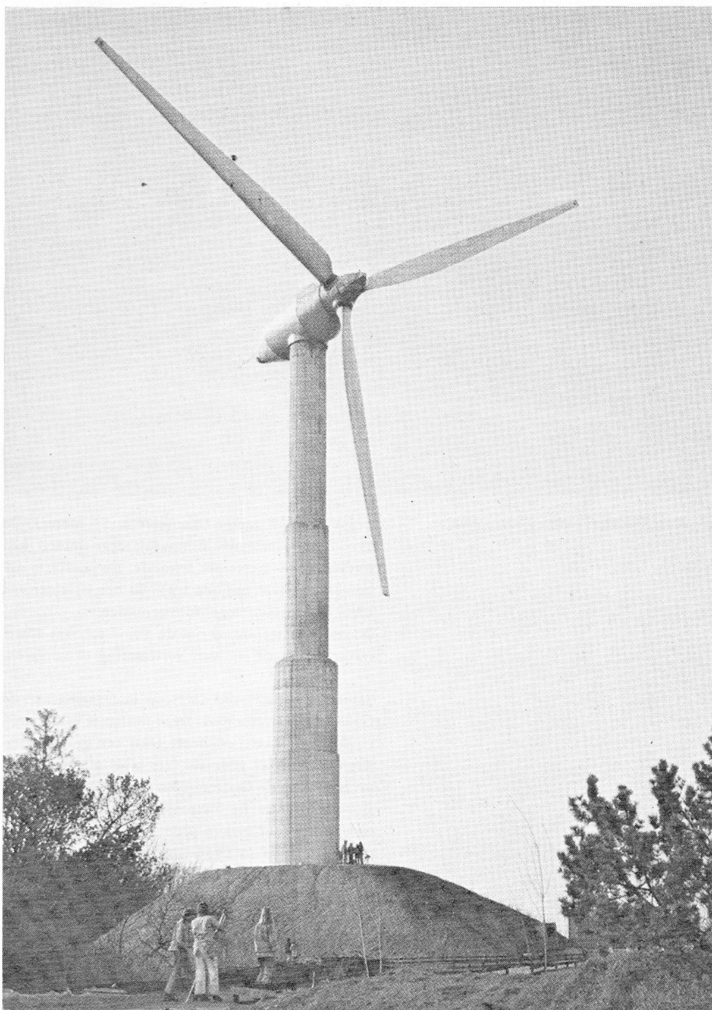
afb. 4.16 De grote molen van Tvind (Denemarken); vermogen 1724 kW; diameter 54 meter.
