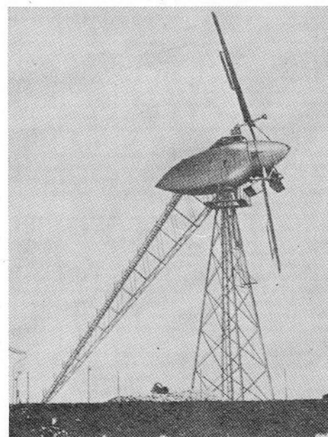
afb 4.3 Jalta windmolen op het schiereiland De Krim, vermogen 30 kW; diameter 30 meter (1931).
