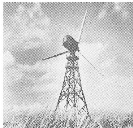
afb 4.11 St. Rémy-des-Landes; vermogen 1000 kW; diameter 35 meter (Frankrijk 1963).
