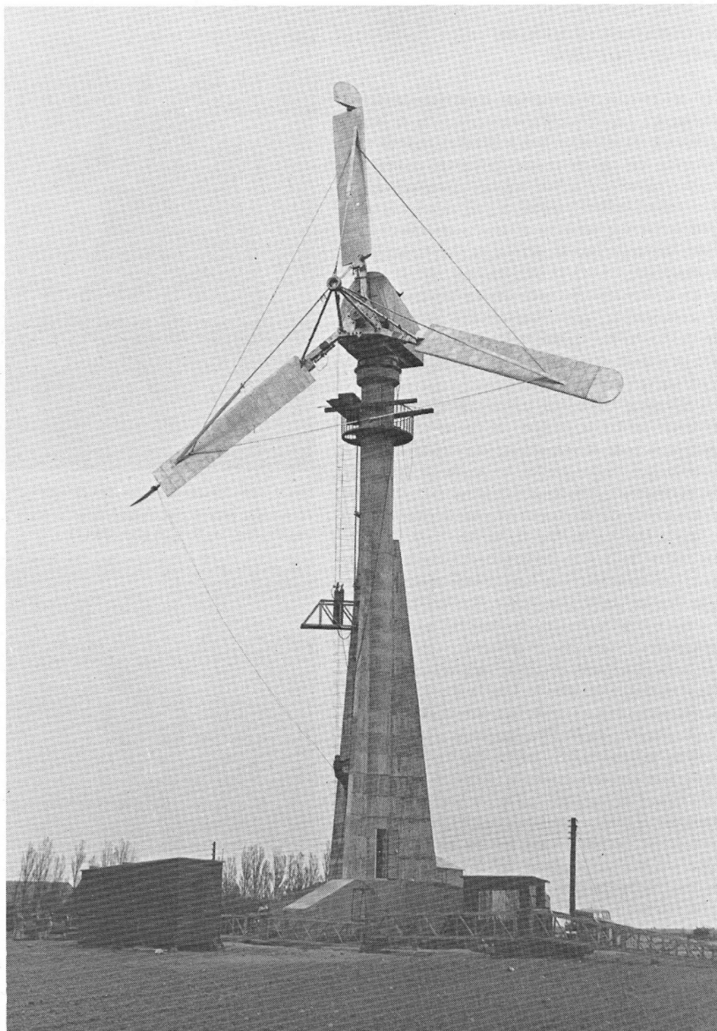
afb 4.8 Gedsermolen; vermogen 200 kW; diameter 24 meter (Denemarken 1957).
