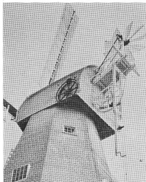
afb 4.2 Oude Engelse molen met een windroos en zelfzwichende wieken. Deense onderzoekers gebruikten deze voorzieningen op hun windgeneratoren.
